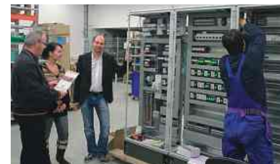
Die gat GmbH ist ein erfahrener Dienstleister in der Elektro-, Mess-, Steuer-, Regel- und Automatisierungstechnik für viele Branchen (z.B. Chemie und Petrochemie, Mineralölindustrie, Gasaufbereitung, Schiffbau, Gebäudeleittechnik, Umwelttechnik) Geschäftsführer Torsten Franke (3.v.l.) erläutert die Herstellung von anschlussfertigen Schalt- und Steuerständen.
